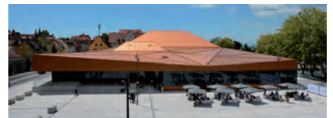
Die rundum erneuerte Inselhalle bietet beste Rahmenbedingungen für das Branchentreffen. (Foto: JT-elektronik/Ulrich Stock)
