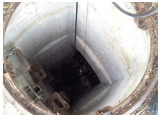
Bild 5: Positionieren des Fahrwagens am Haltungsanfang
