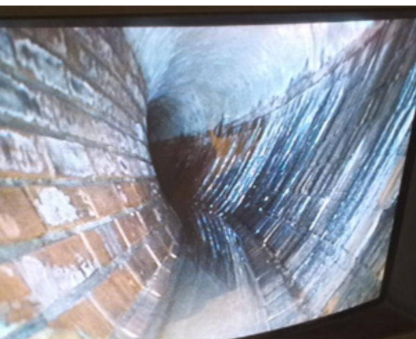
Bild 6: a) Gebogener Eiprofilverlauf (Haltung FM-83),
