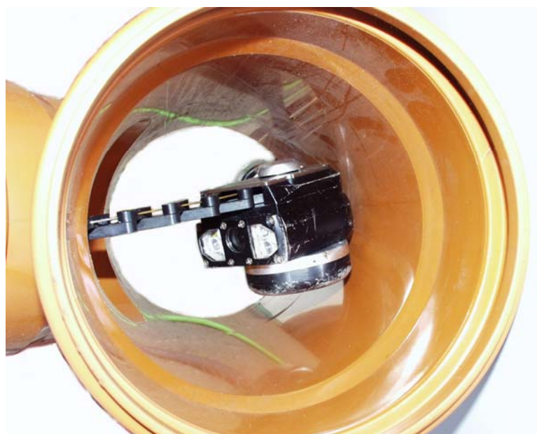
Schere vor Abzweig im Kanal, abbiegen in den rechten Abzweig
